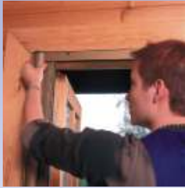
Sovita yläkisko kasettiosaan ja työnnä se kiinni edellisen kuvan vastakappaleeseen. Kiinnitä yläkisko.
